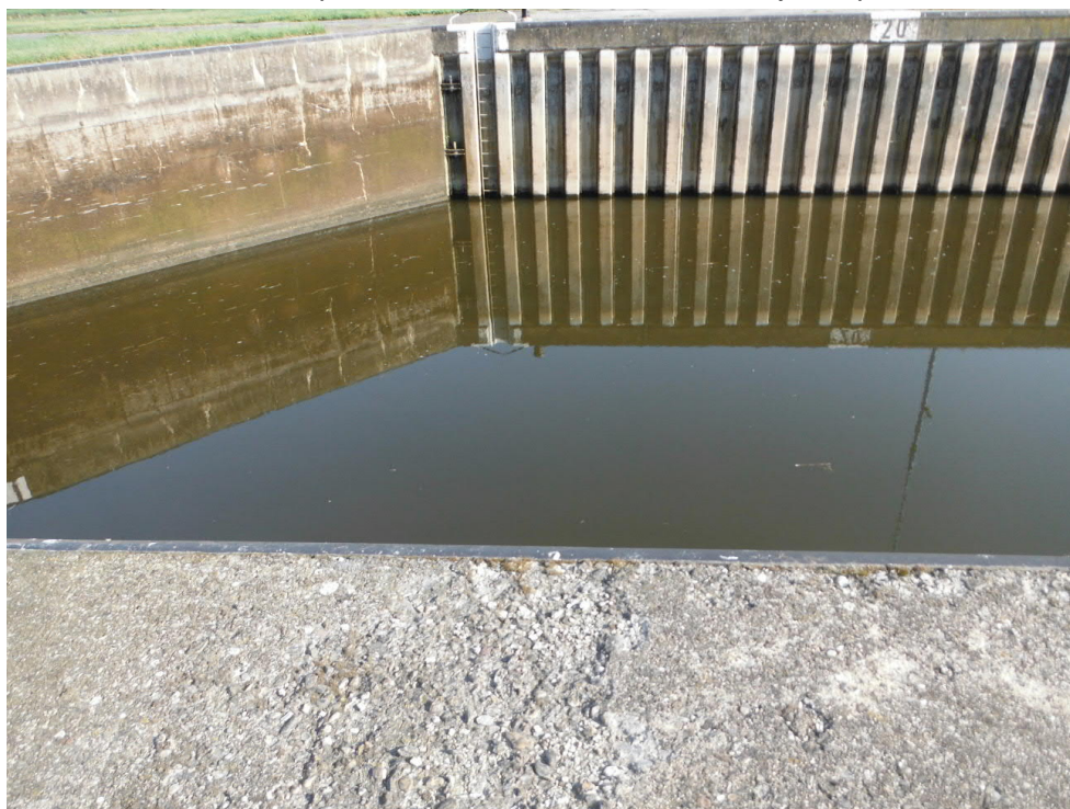
obr. č. 12 Plošná destrukce povrchu betonové konstrukce stávajícího plata
