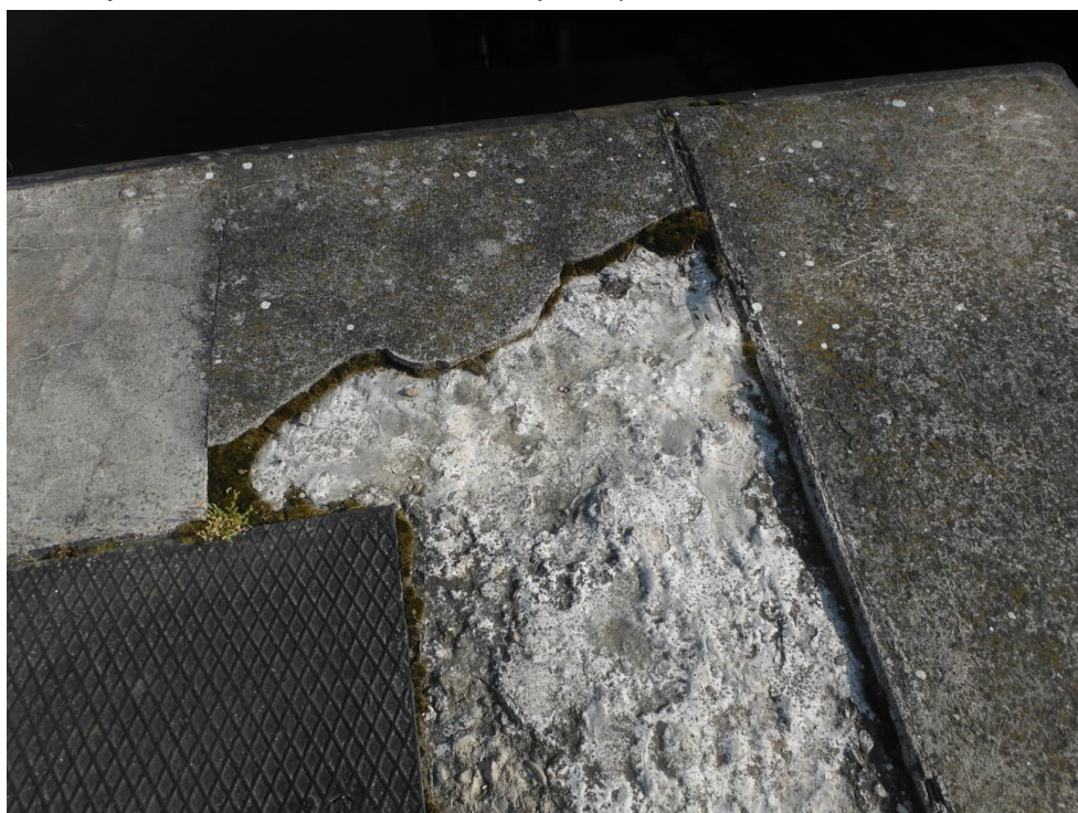
obr. č. 10 Výtluk v betonové konstrukci stávajícího pláta
